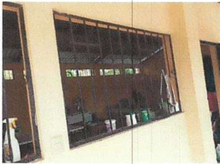
Foto 3: Se instalaran ventanas en parte frontal
